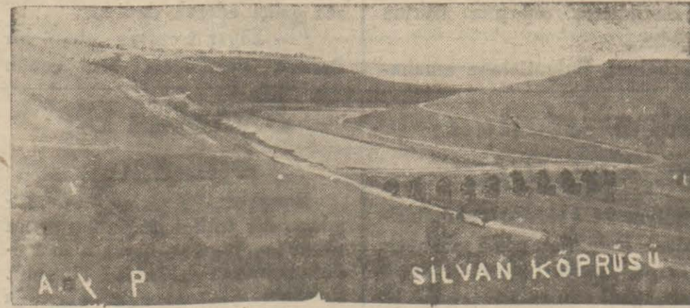
Dicle nehri üzerindeki Silvan köprüsü:
